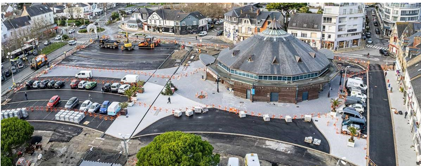
Le chantier de la place du marché
