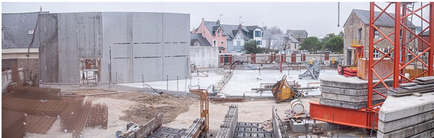
Le chantier du cinéma
