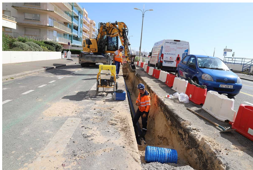
Le chantier du Front de mer secteur Mazy
