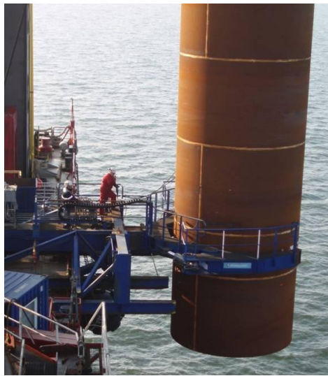
Figure 3 : Descente du monopieu dans son guide (source DONG Energy).
