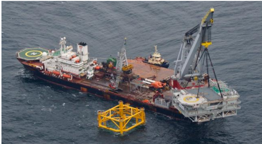
Figure 7 : Installation d'une sous-station (source DONG Energy).
